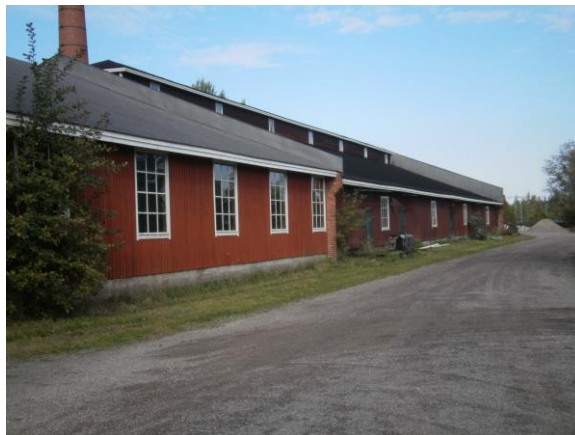
Liite 6.2 Jokelan tiilitehdas
