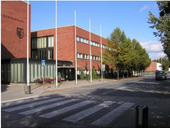
Liite 6.1 Purettava hallintorakennus
